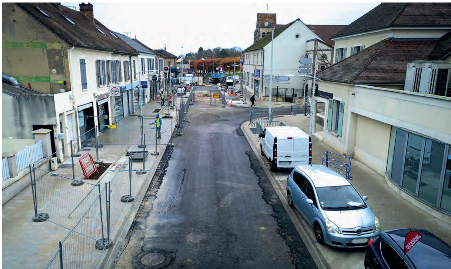
Les travaux avenue Philippe Bur.
